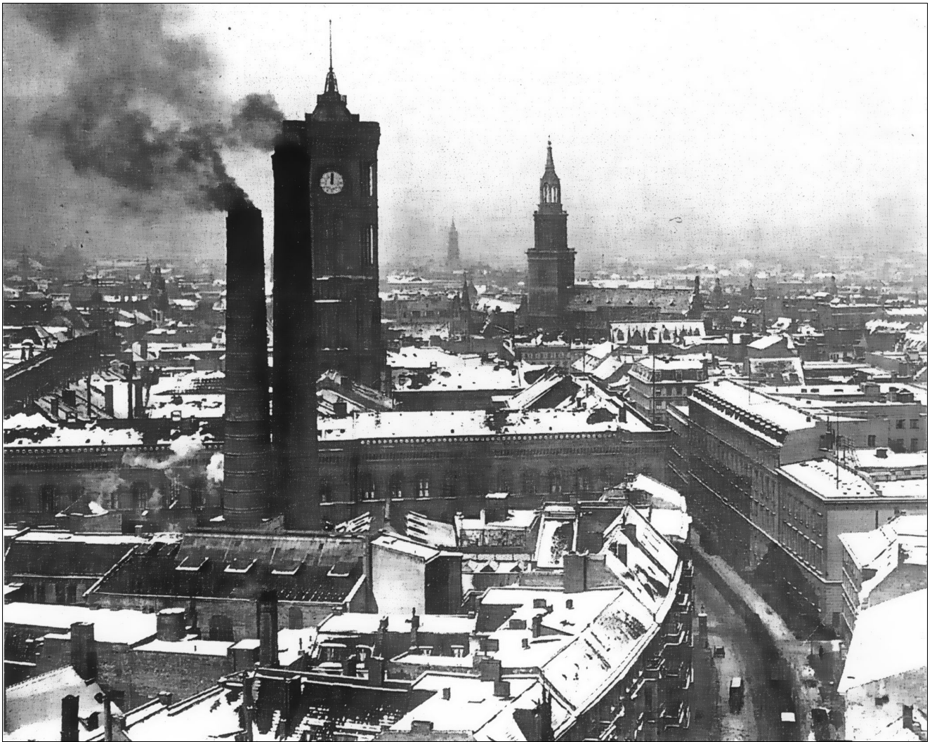
Bild 33: Das am 1. Oktober 1899 in Betrieb genommene dritte Berliner Kraftwerk in der Rathausstraße (heute Gustav-Blöß-Str.) (um 1920)
