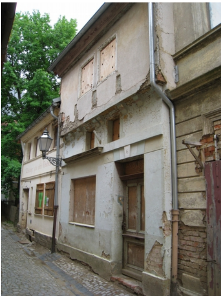
Bild 10: Ein weiteres Handwerkerhaus in Aschersleben, Teil des sog. Halkens; mit diesem Ensemble hat sich ein Rest spätmittelalterlicher Bausubstanz erhalten [Foto: Michael Weigel, 2014]
