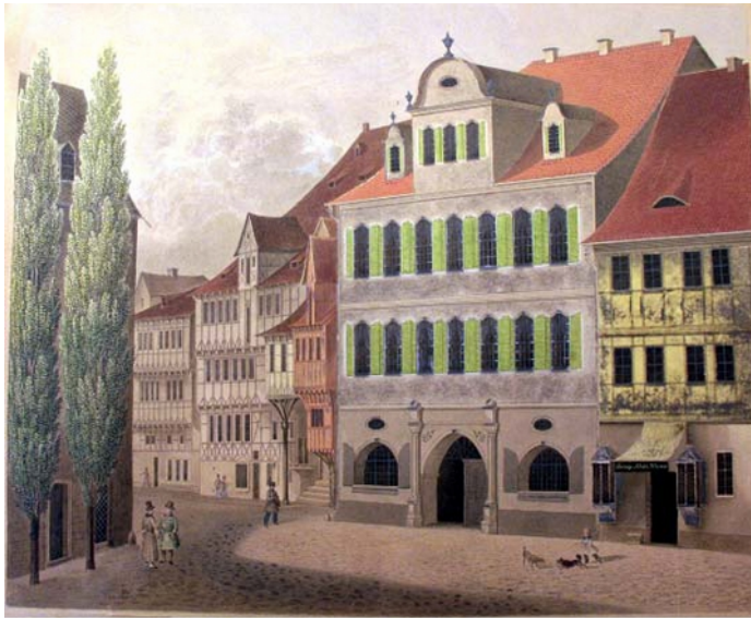
Bild 12: Die ersten reinen Wohnhäuser entstehen, hier das Haus der Familie Steuerwald in Quedlinburg; zu damaliger Zeit von Stiftsbeamten bewohnt, die weder Werkstatt, Kontor noch Lager benötigten, wohl aber repräsentieren mussten. Aus den Ladeluken der Lastkräne in Kaufmannshäusern (siehe Bild 8) wurden als reine Stilelemente die Dachgauben [Werk ist gemeinfrei (Urheberrechte aufgrund des Alters abgelaufen)]
