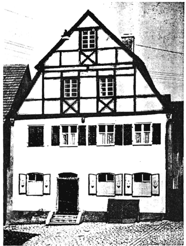
15. Haus 52 (am ehemaligen Schloßhof)
