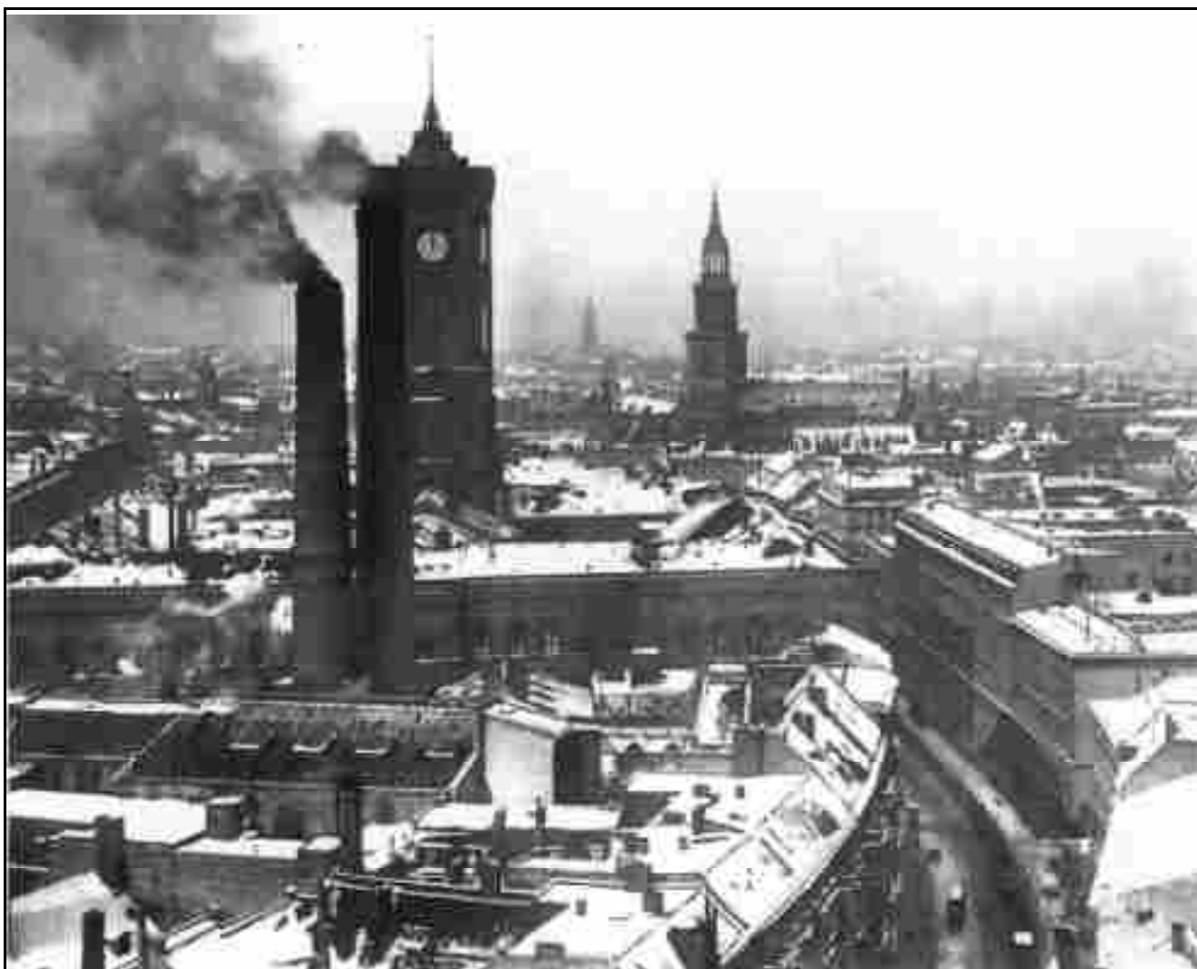
Bild 33: Das am 1. Oktober 1899 in Betrieb genommene dritte Berliner Kraftwerk in der Rathausstraße (heute Gustav-Blöß-Str.) (um 1920)
